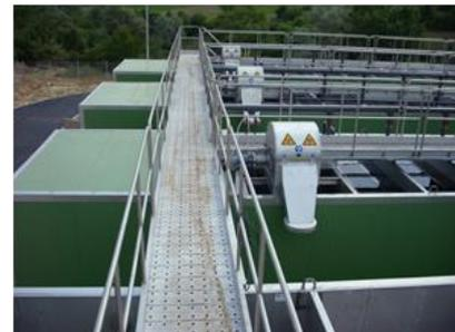
Über einen Bediensteg sind die Becken der Anlage zu erreichen. Dieser führt über die Vorklärbecken, Biostufen, Schlammkammer und die Nachklärbecken.
